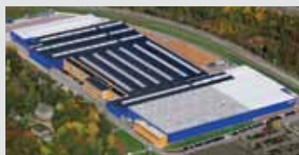
Hörmann KG Eckelhausen, Allemagne
